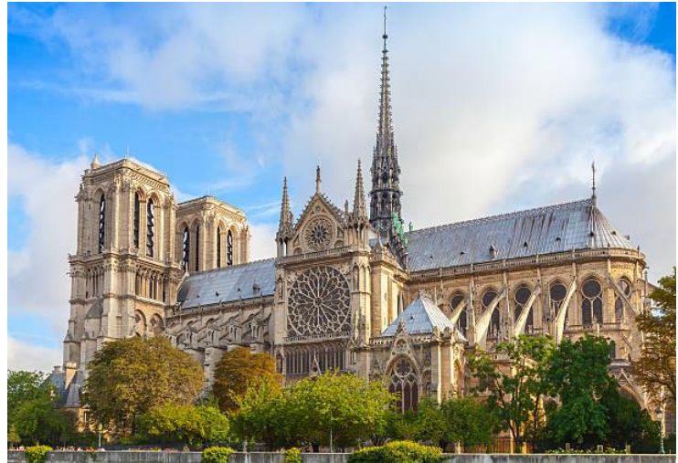
Estructura exterior y arbotantes
